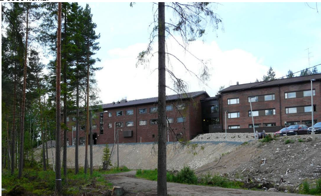
Päärakennuksen vanha osa ja uudisosa pysäköintialueen suunnasta
