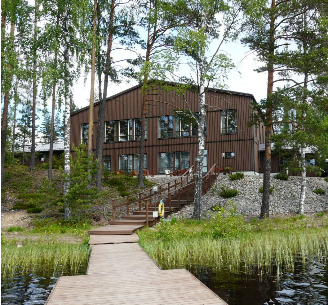
1980-luvun alussa valmistunut majoitus- ja ravintolarakennus
