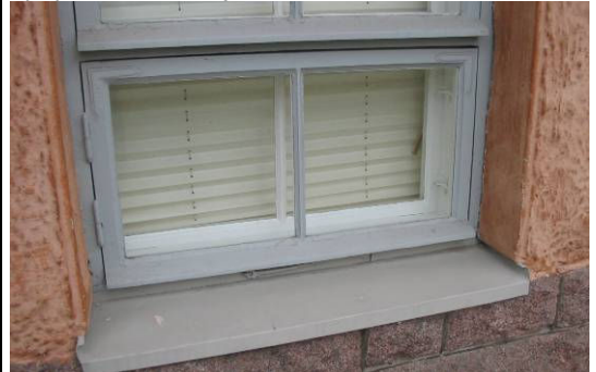
Alkuperäinen sisään-ulos aukeava puuikkuna perinteisellä tippanokalla.
