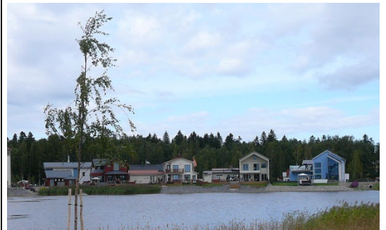
Kuvan moderni rantarakentaminen on liian tiivistä eikä suojapuusto maisemoi rakentamista lain- kaan.
