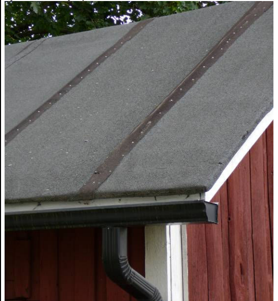
Kolmiorimahuopakate ja rimalaudoitus edustavat perinteisiä ja edelleen käyttökelpoisia rakennustapoja, vajaasärmäisestä laudasta tehty lomalaudoitusta esiintyy enää vain vanhoissa talousrakennuksissa.
