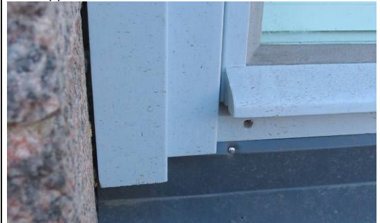
Tehdasvalmisteinen sisään-sisään aukeava puuikkuna, jossa on tippanokka säilytetty osana ulkoasua.
