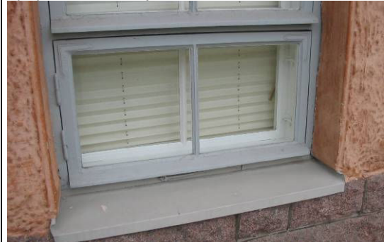
Alkuperäinen sisään-ulos aukeava puuikkuna perinteisellä tippanokalla.
