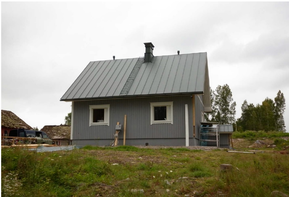
Talouskeskuksen kunnostettu vanha asuinrakennus
