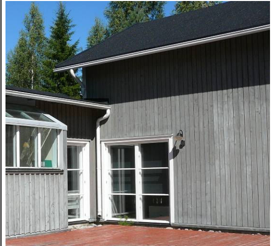
Materiaalien ja mitoituksen ollessa oikeat, voidaan ikkunoinnissa ja julkisivujen käsittelyssä käyttää modernijakin keinoja.
