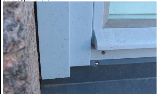
Tehdasvalmisteinen sisään-sisään aukeava puuikkuna, jossa on tippanokka säilytetty osana ulkoasua.
