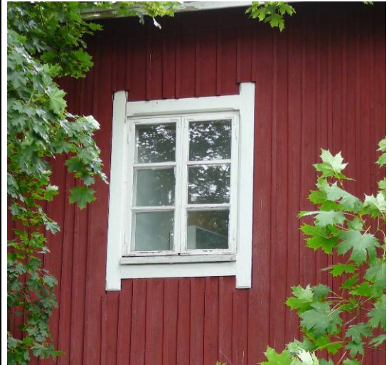
Kolmiorimahuopakate ja rimalaudoitus edustavat perinteisiä ja edelleen käyttökelpoisia rakennustapoja, vajaasärmäisestä laudasta tehty lomalaudoitusta esiintyy enää vain vanhoissa talousrakennuksissa.
