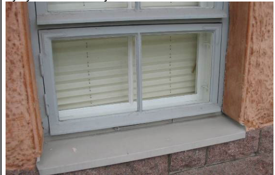
Alkuperäinen sisään-ulos aukeava puuikkuna perinteisellä tippanokalla.
