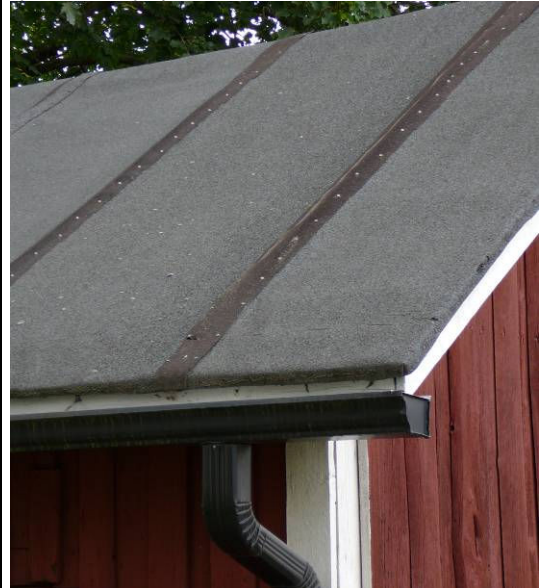
Kolmiorimahuopakate ja rimalaudoitus edustavat perinteisiä ja edelleen käyttökelpoisia rakennustapoja, vajaasärmäisestä laudasta tehty lomalaudoitusta esiintyy enää vain vanhoissa talousrakennuksissa.
