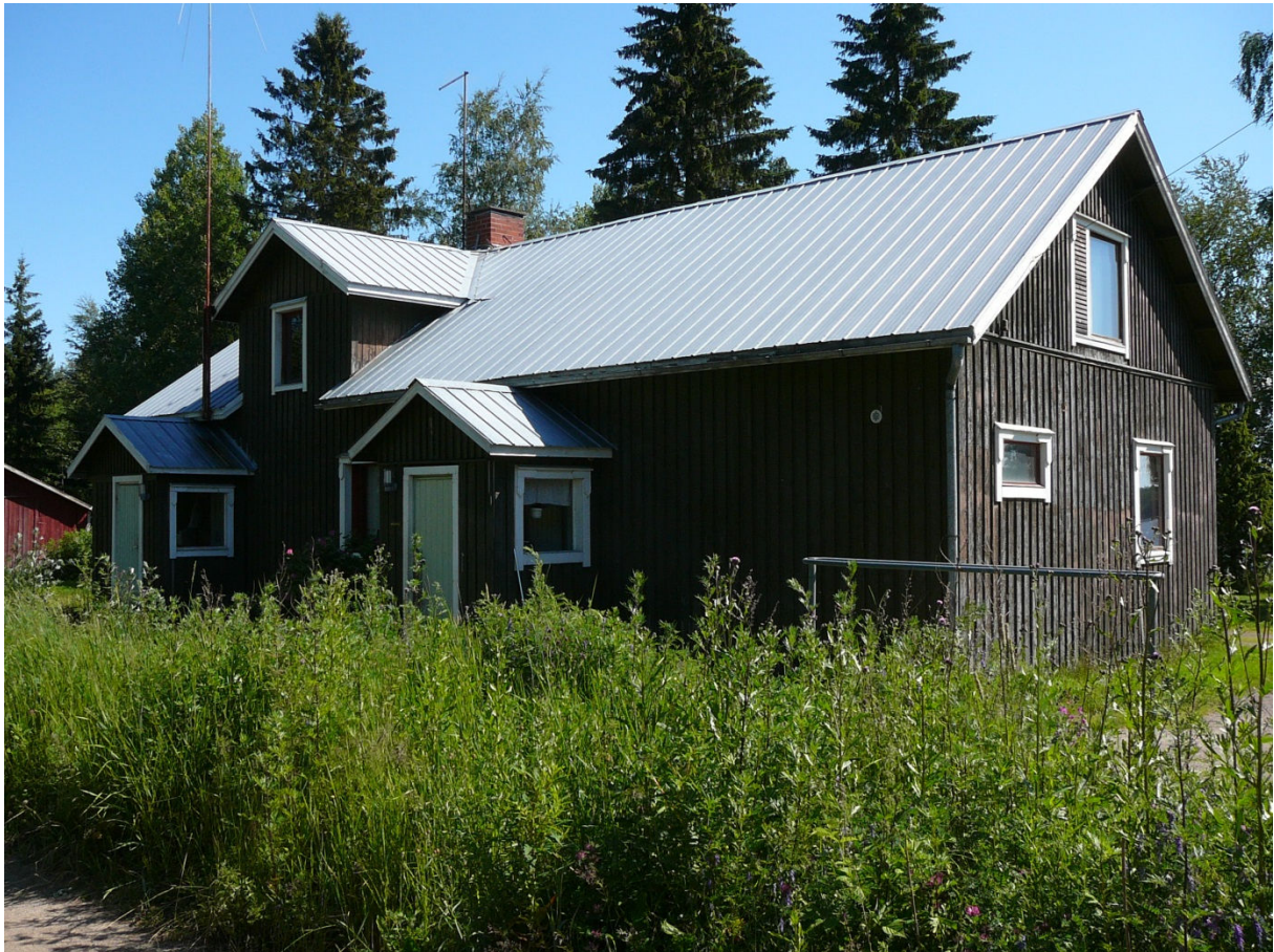
alueen kolmesta asuinrakennuksesta vanhin Tarttilan asuinrakennus
