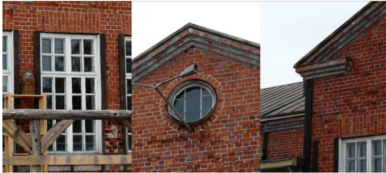
meijerirakennuksen alkuperäisiä yksityiskohtia: vasemmalla alkuperäisiä puisia ruutuikkunoita ja tiiliseinädetaljointia, keskellä alkuperäinen pyöreä koristeikkuna ja tiiliseinädetaljointia, oikealla alkuperäistä räystääsdetaljointia ja tiiliseinädetaljointia sekä alkuperäistä / alkuperäistä vastaavaa konesaumapeltikatetta
