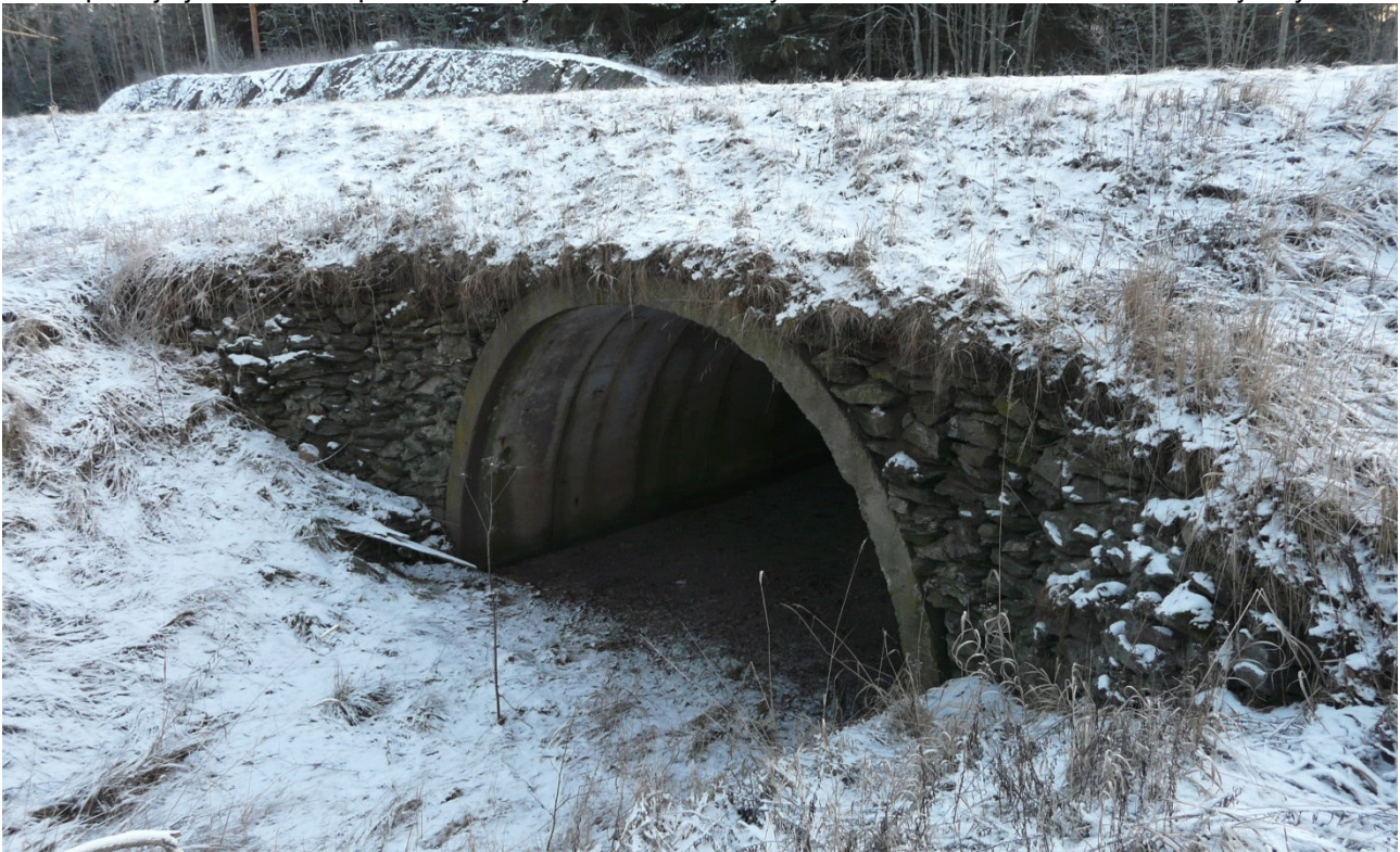
Mustialan kohdalla oleva valtatie 10 alikulku
