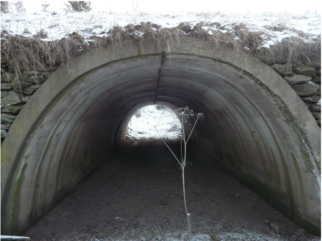
Karjan kulkemiseen tarkoitettu alikulku 1 Mustialassa
