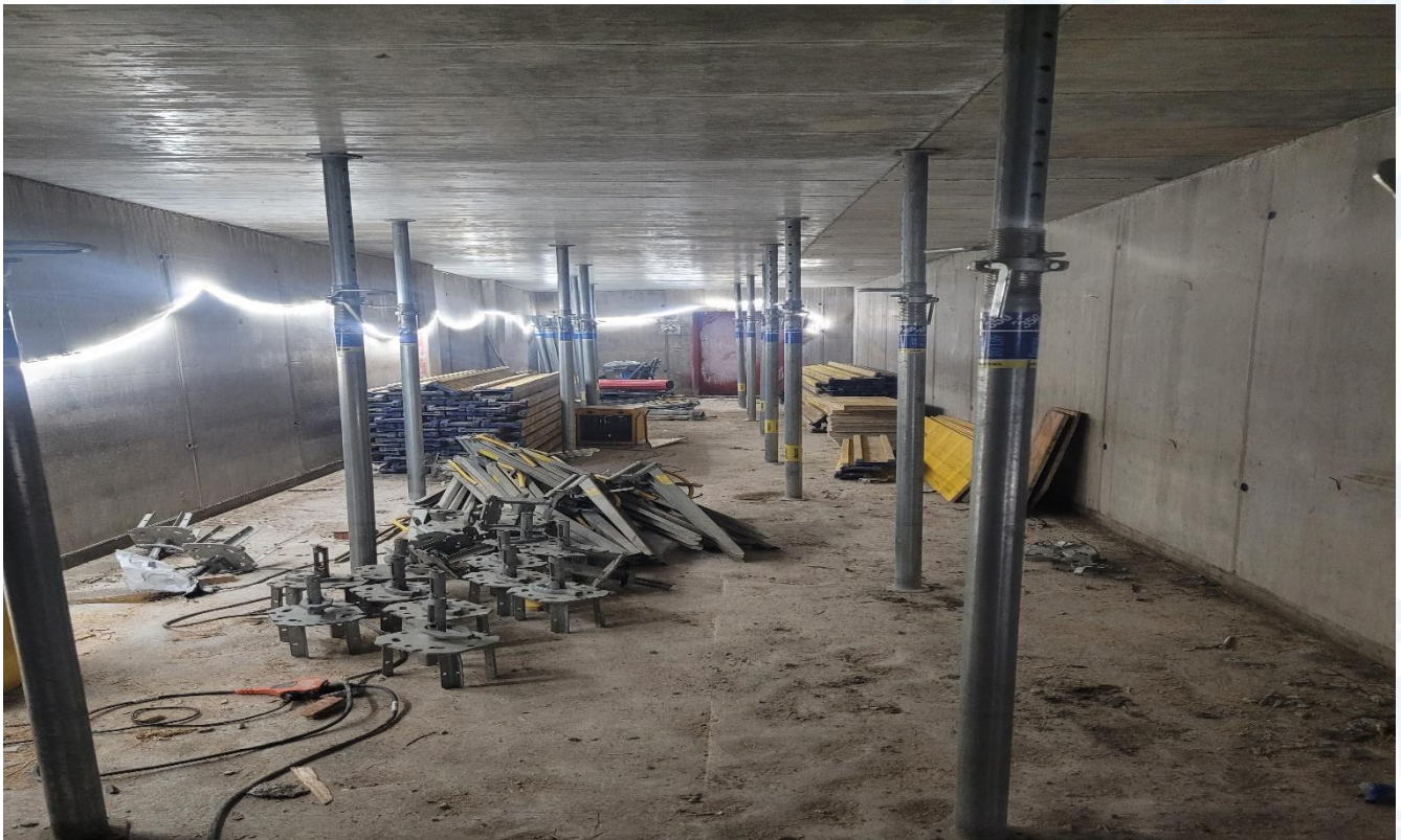
Vss:n välipohjan purettu muotti ja jälkituenta
