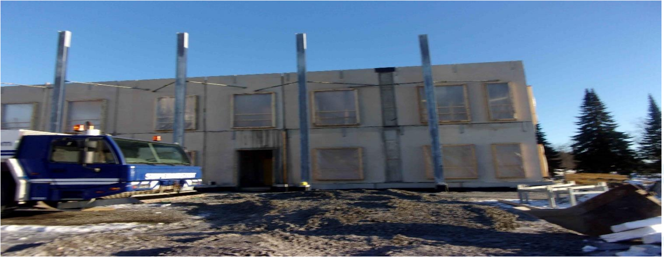
Teräspilariasennus ja rakennuksen ympärystäyttö
