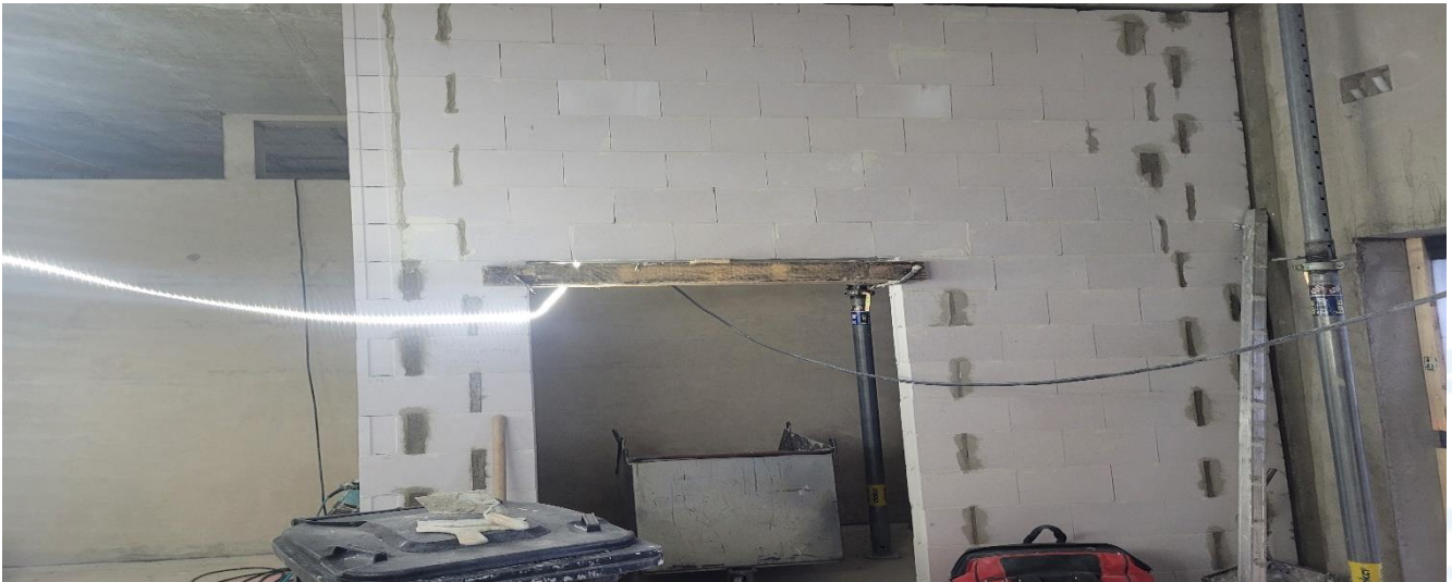
Väliseinämuraus käynnissä
