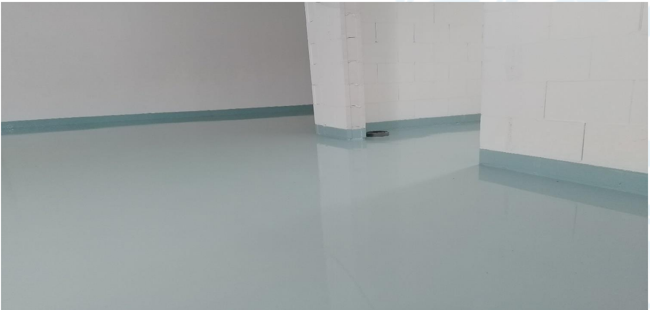
Lämmönjakohuoneen lattiapinnoitus
