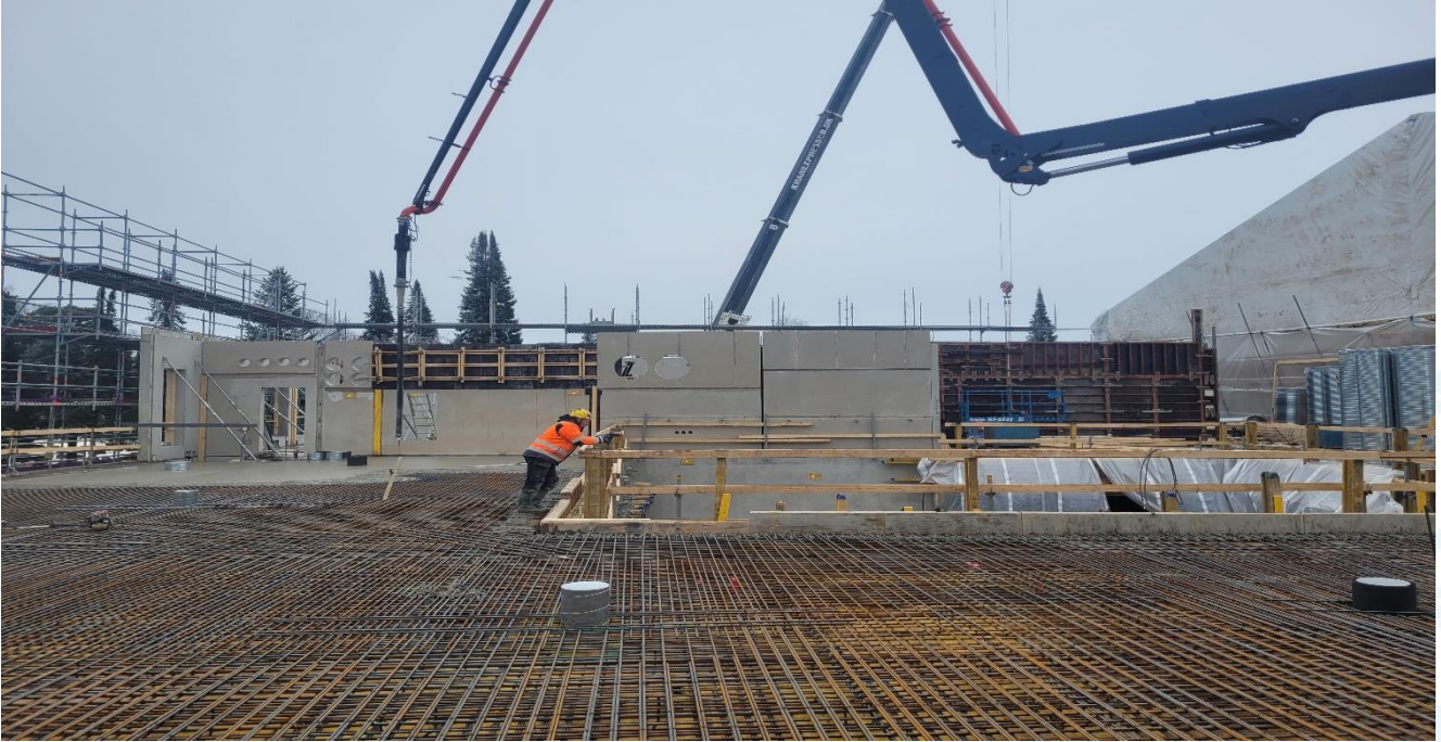
2. kerroksen katon loppu betonointi
