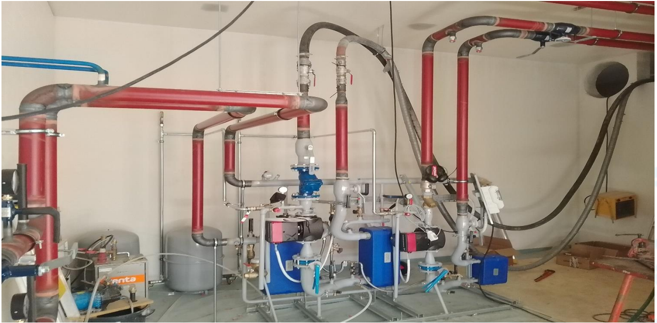
Lämmönjakokeskus
