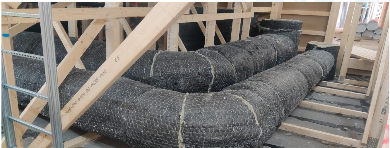
Yläpohjan kanavaeristystä
