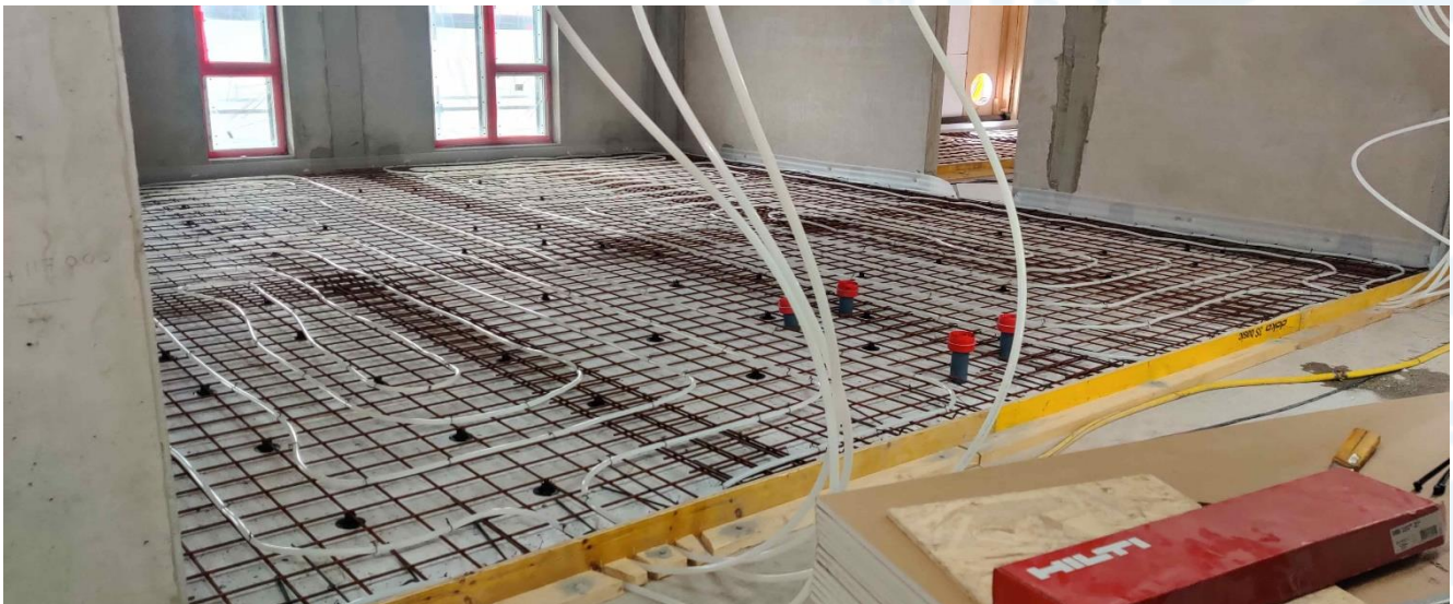
Lattialämmitysputkistoasennus
