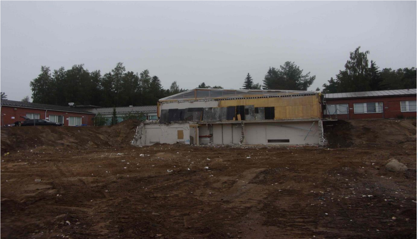
1. vaiheen purkutyö tehty
