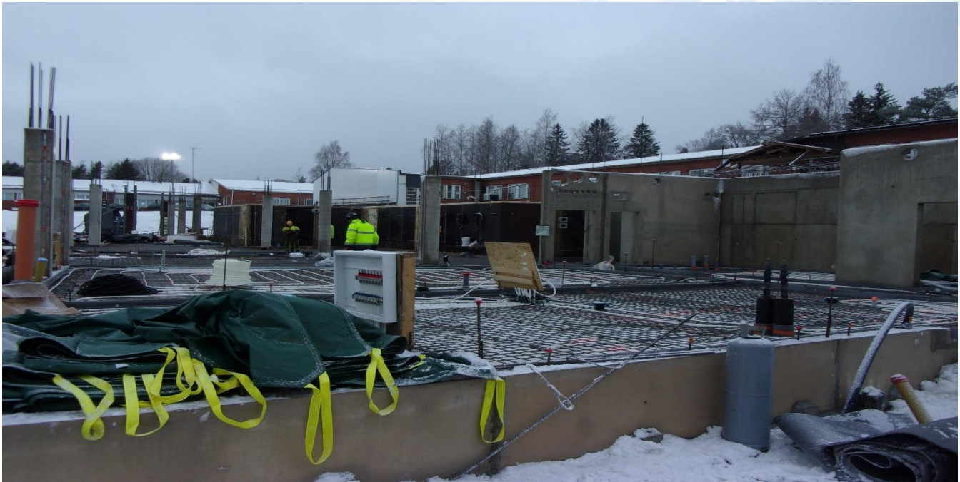
Viimeisen alapohjalohkon betonoinnin valmistelu
