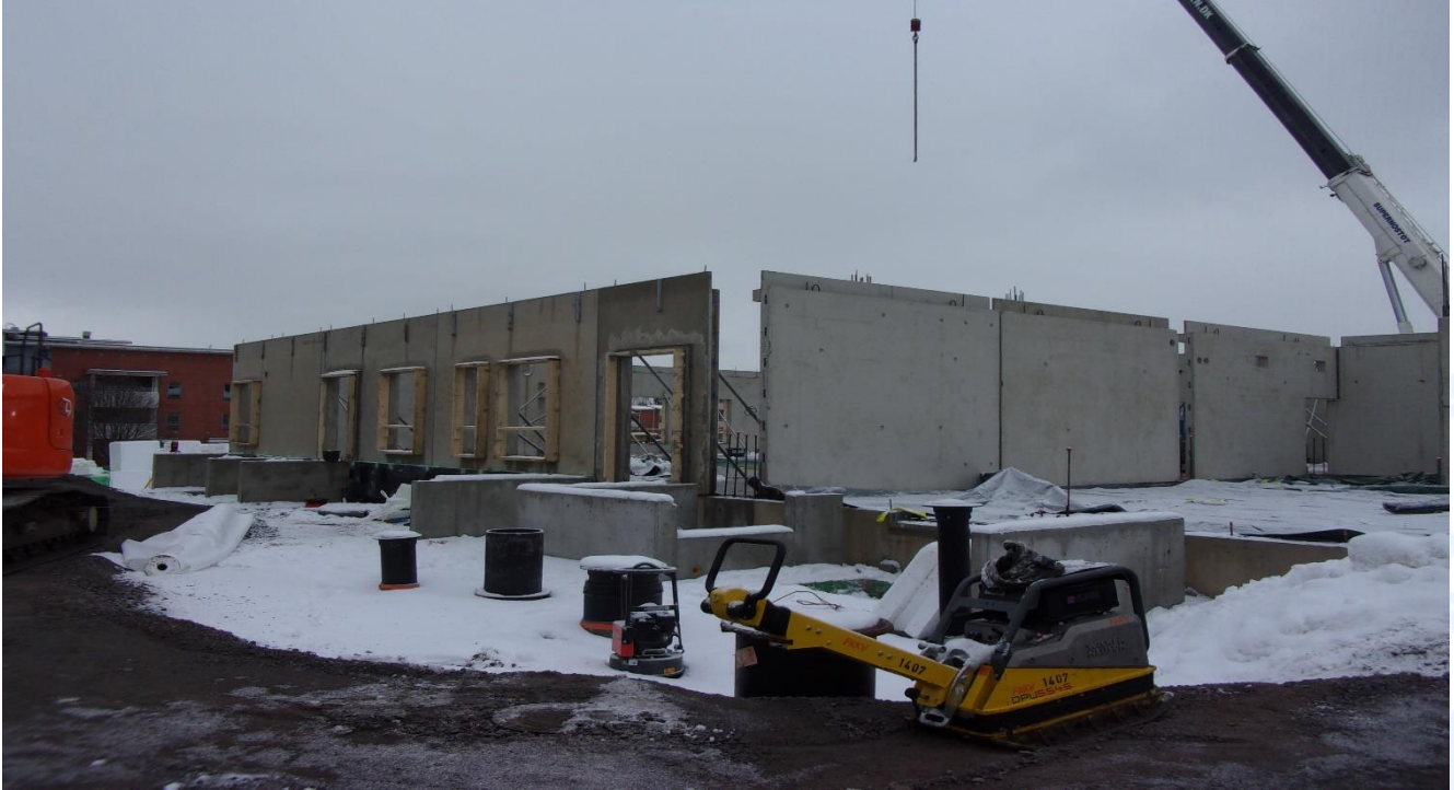
1. kerroksen seiniä asennettu
