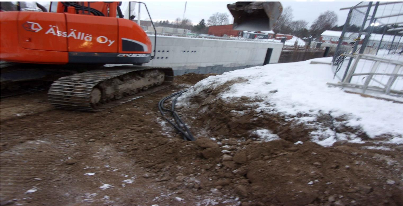
Sähkön liittymiskaapelit tuotu
