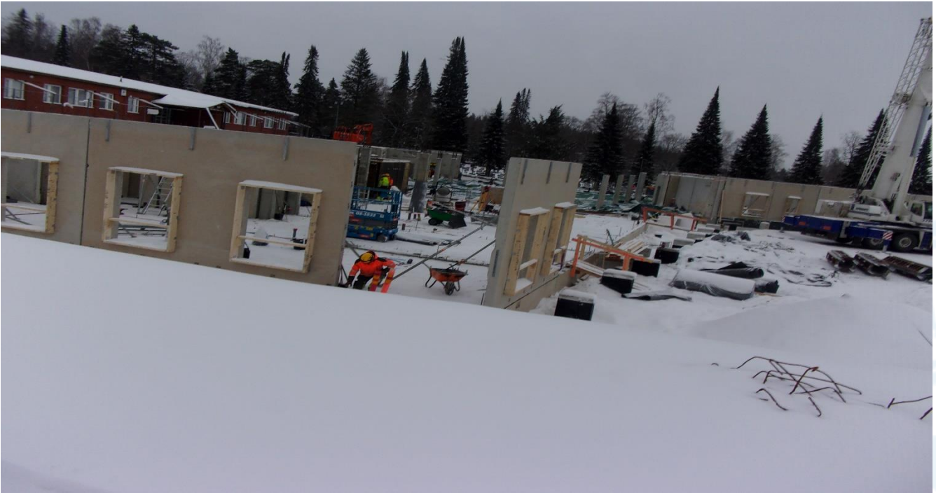
Seinäelementtiasennus osa A
