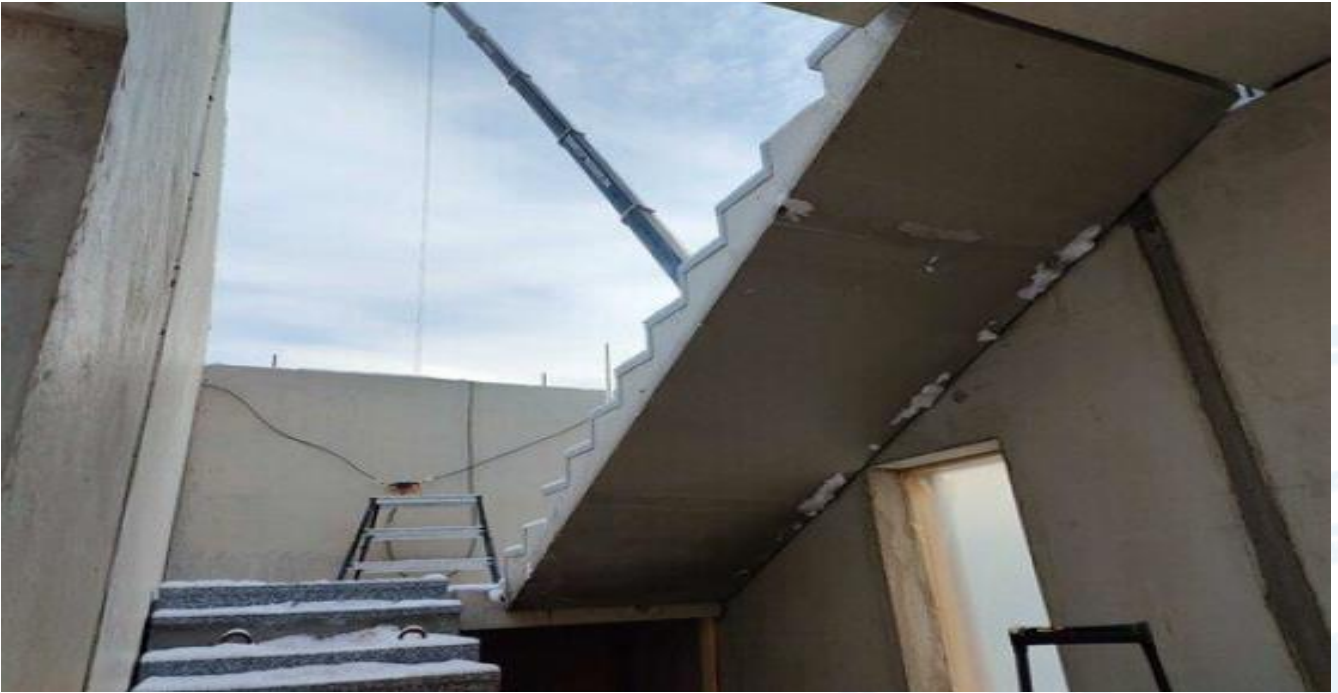
1. kerroksen porraselementit asennettu
