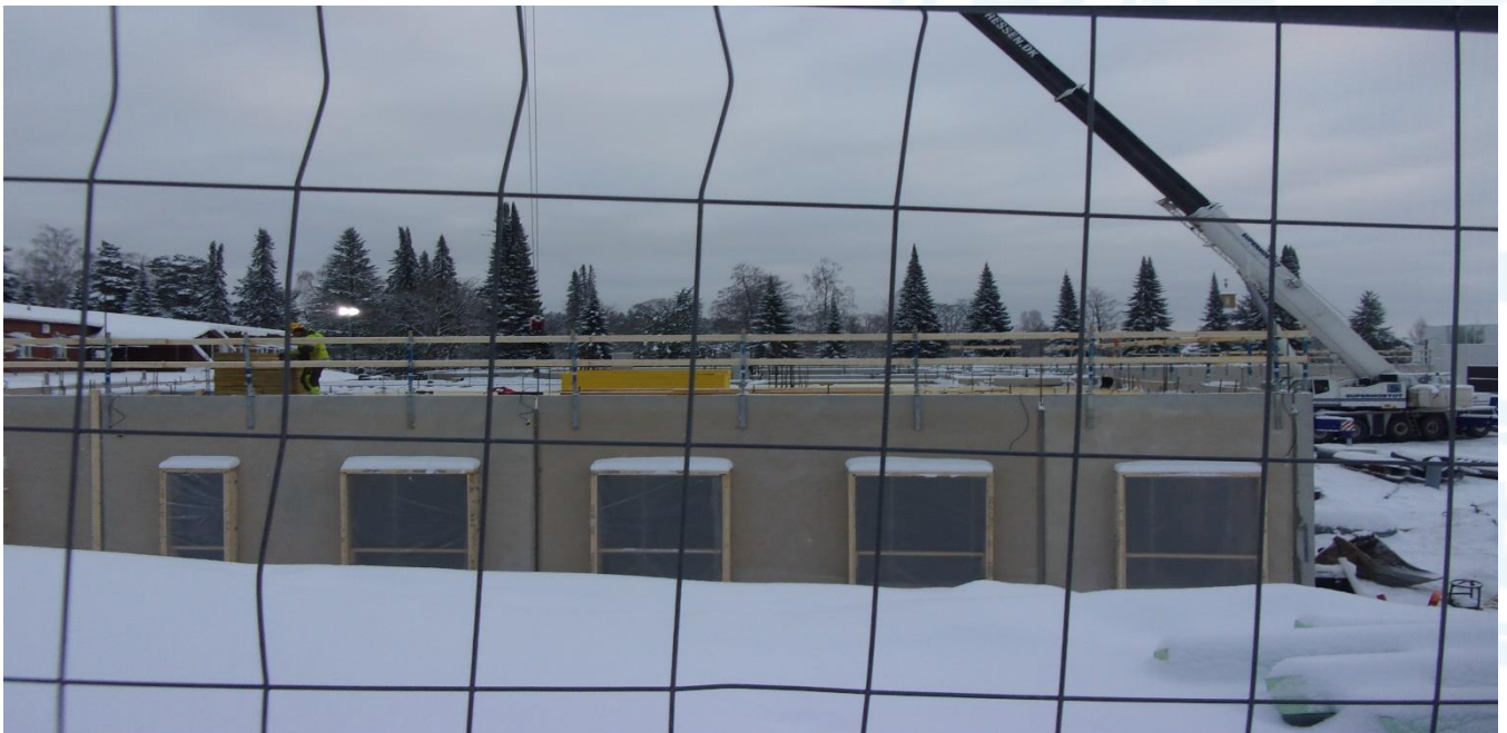
1. kerroksen katon muottityö osa A
